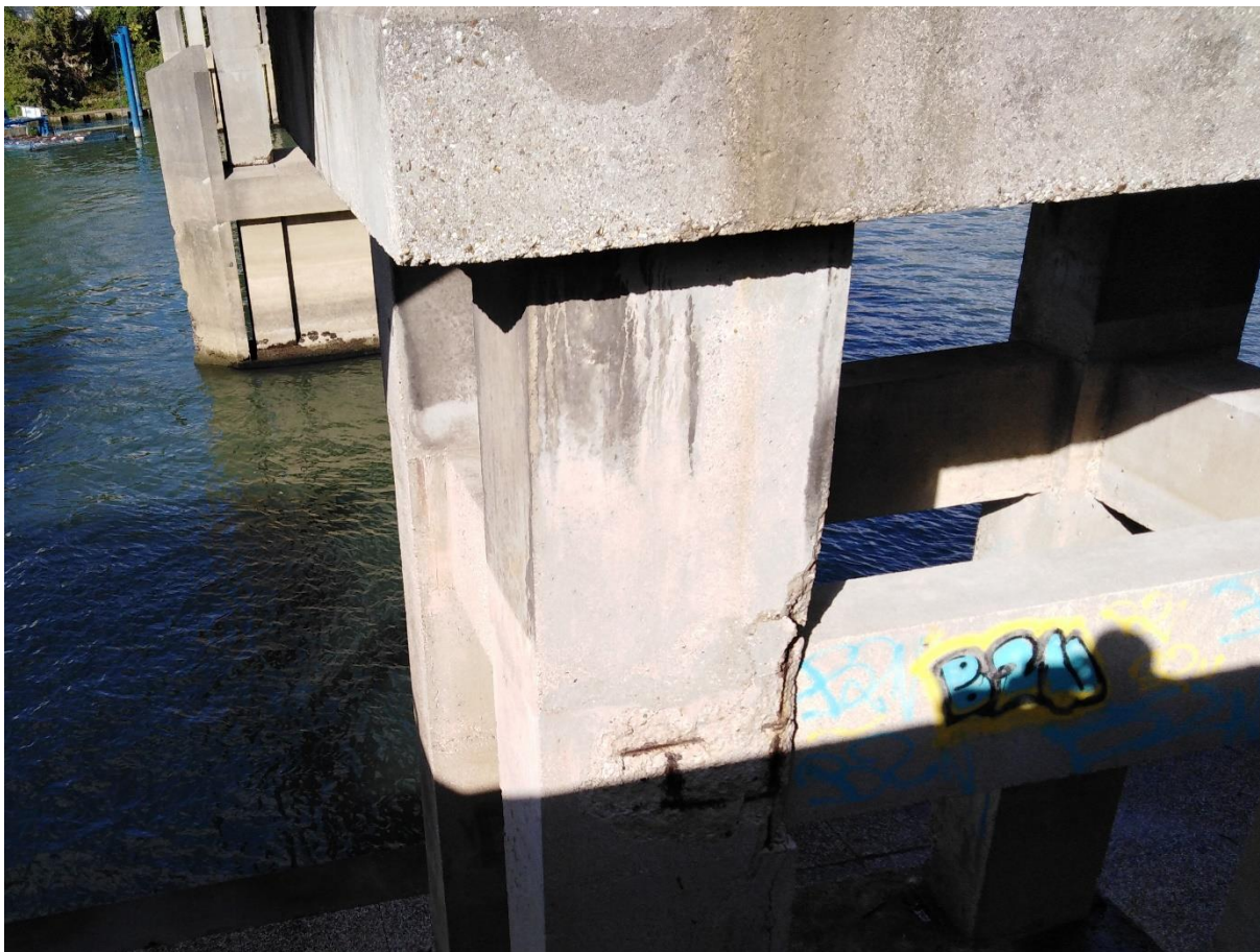
Photographie des piliers du pont d'Alfortville depuis la rive gauche côté Alfortville, octobre 2021.
